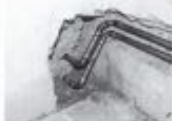
Weichgelötete Rohre
