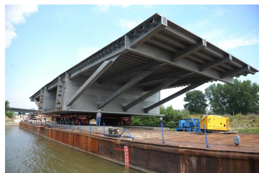
Beispielhafte Anordnung von Trapezsteifen am Deckblech
